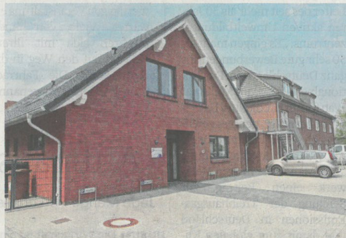
Der Neubau (l.) ist direkt mit dem bisherigen Gebäude verbunden.
